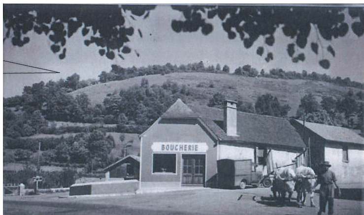
Vu de l'emplacement des feux tricolores, le boala de haut avant 1975 était une pâture
